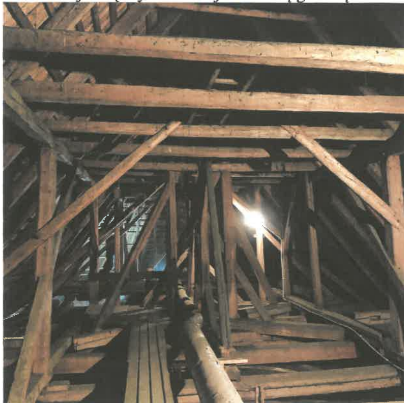
Konstrukcja więźby dachowej nad nawą główną kościoła:
