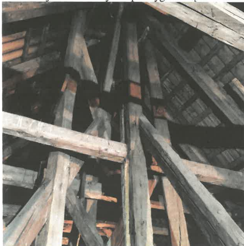
Konstrukcja nośna wieżyczki pod sygnaturkę:
