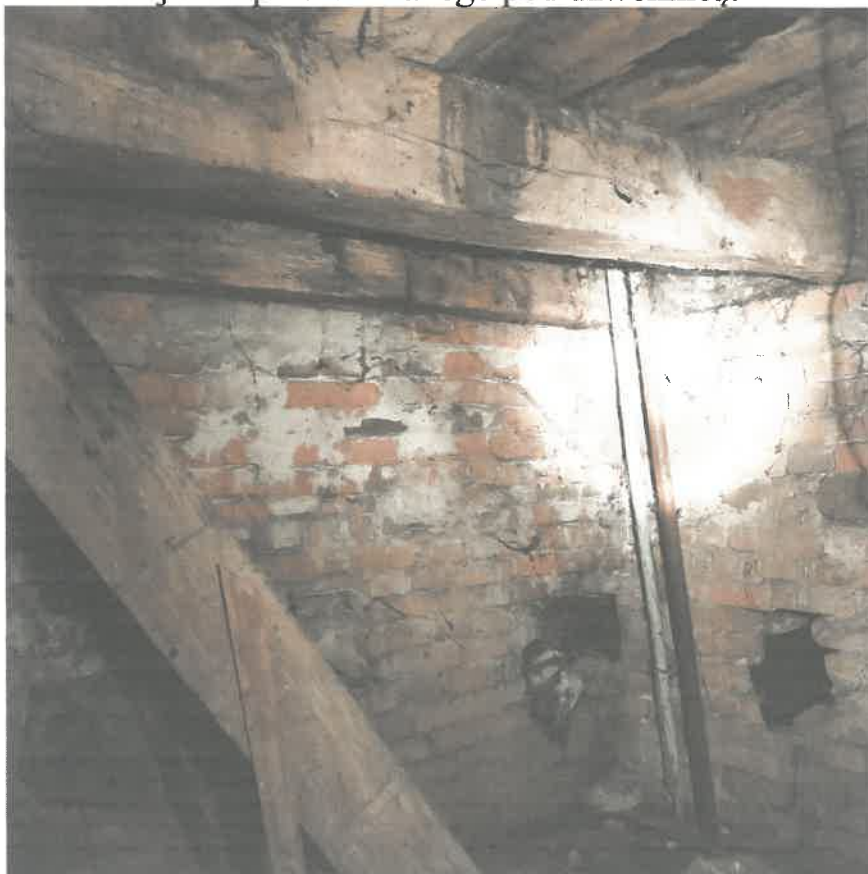
Konstrukcja stropu drewnianego pod dzwonnica:
