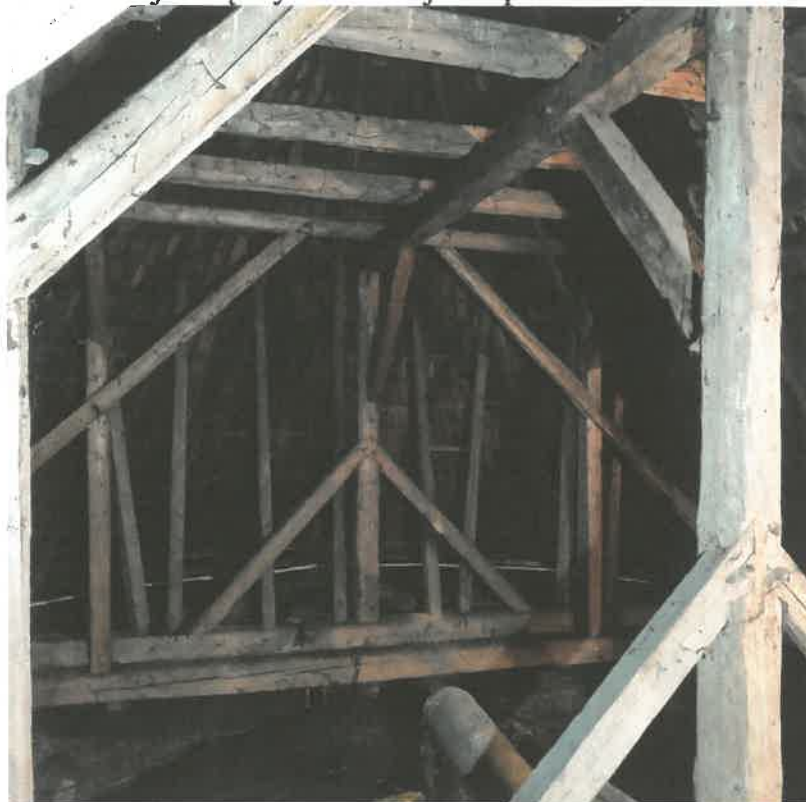
Konstrukcja więźby dachowej nad prezbiterium:
