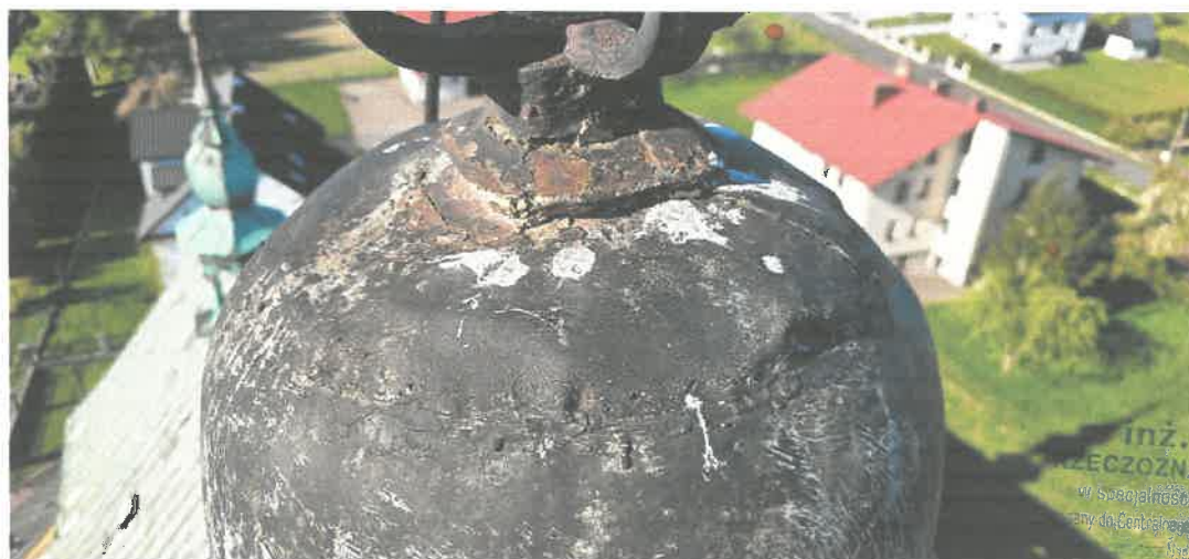
Widok zniszczonego mocowania krzyża i hełmu wieży głównej:
