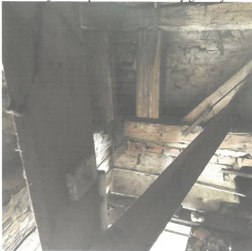
Konstrukcja nośna pod zadaszenie wieży głównej:
